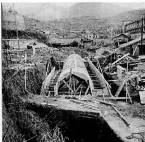
坂本町無筋コンクリートアーチ水路工事枠 (S.25.1)
