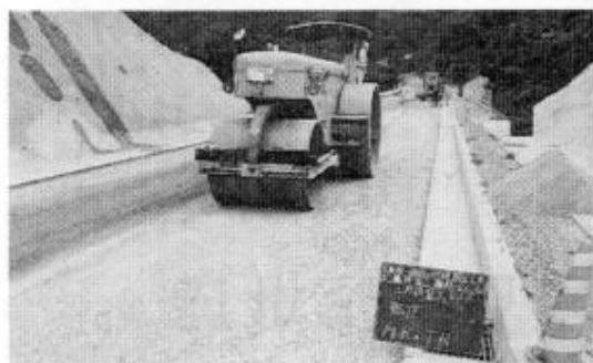
国道207号舗装新設 (S.61)
