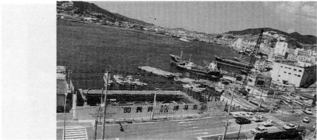
松ヶ枝橋梁埋立 (H.1)
