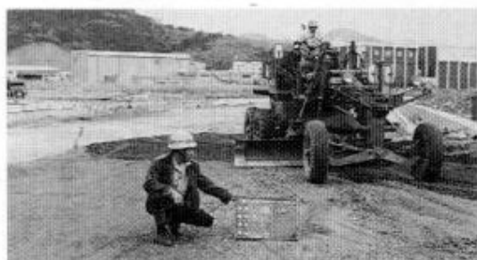
三重新長崎漁港修築 (S.61)
