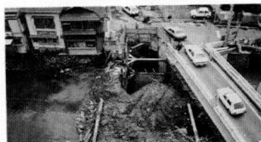
常盤橋架替下部工事 (S.62)
