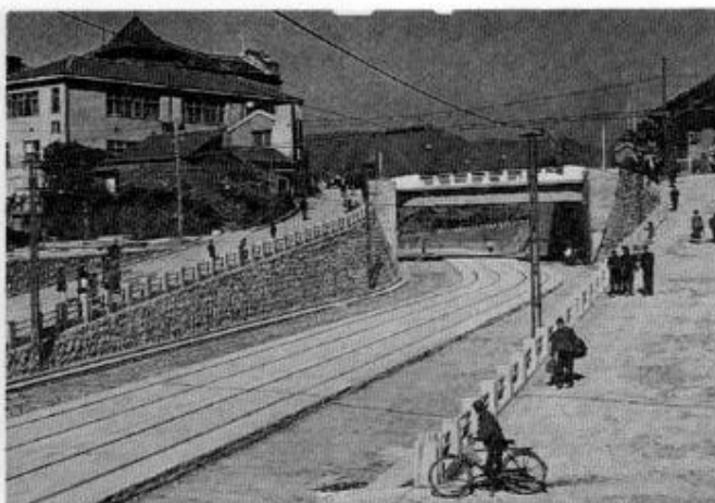
桜町立体交差竣工
