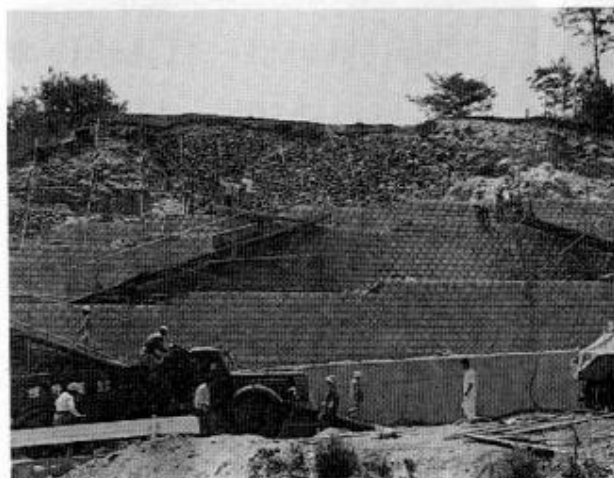
島原工区災害復旧 (S.38)
