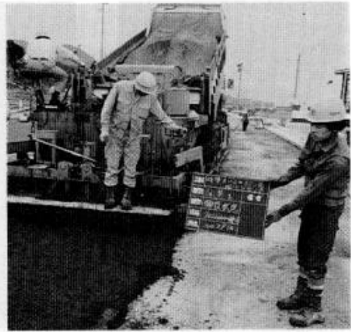
時津8工区国道舗装
