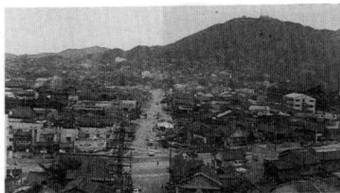
稲佐立体交差着工前
