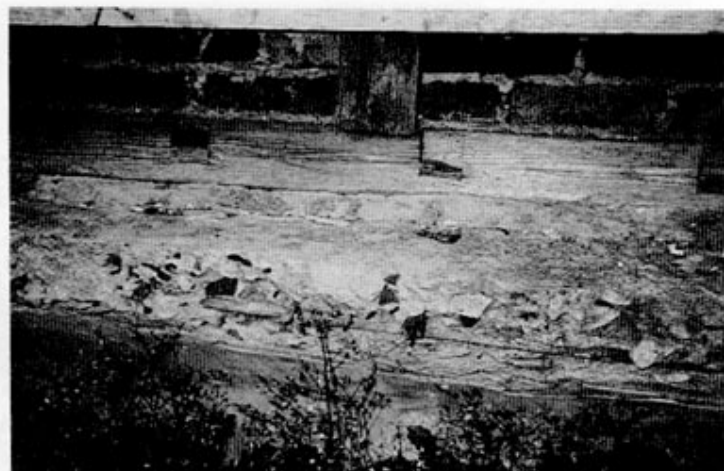
竹筋コンクリート
