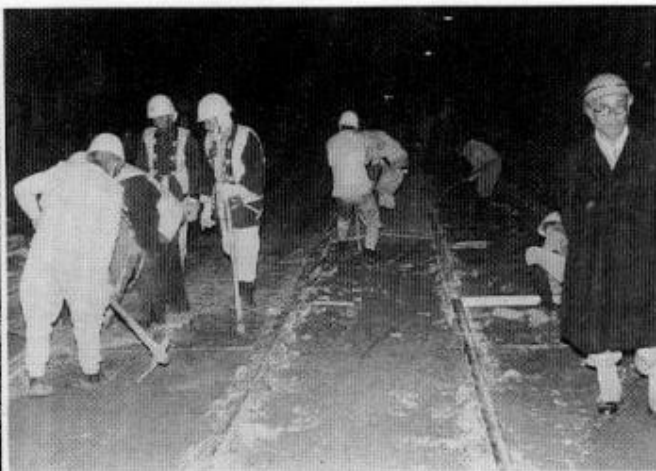
電車軌道工事・黄色安全チョッキ
