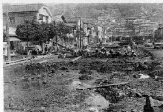
稲佐立体交差ベルトコンベアーによる床掘
