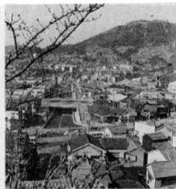
稲佐立体交差竣工
