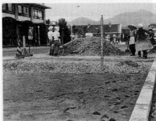
桜町市役所前外浦馬町線路築造現国道34号
