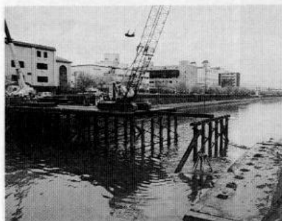
竹岩橋架替の為の仮設橋 (S.63)
