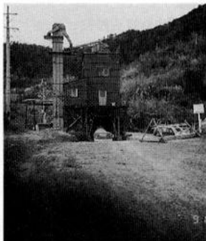
崎戸町平島生コンプラント (H.3)
