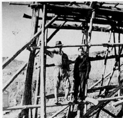
坂本町医大横～浦上天主堂への道路工事現場 (S.25.1)
