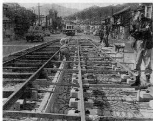
中川地区軌道工事スベンスワールリング (S.39)
